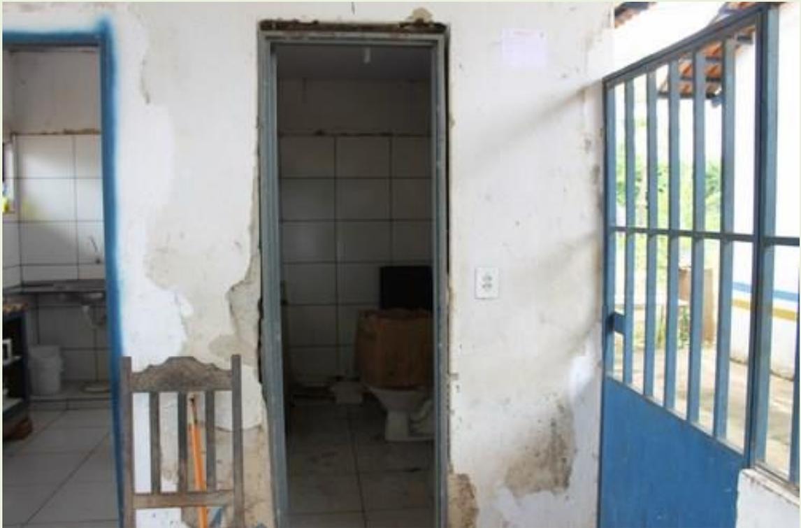
4. Banheiro precisa de porta nova e paredes necessitam de reformas e pinturas;
