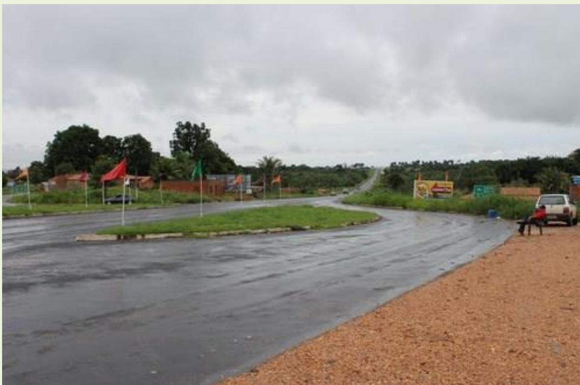
17. Trevo de entrada e acesso ao posto com alto índice de acidentes, colocando em risco a vida dos auditores. Falta de redutores e lombadas para redução de velocidades dos caminhões e veículos de passeio;
