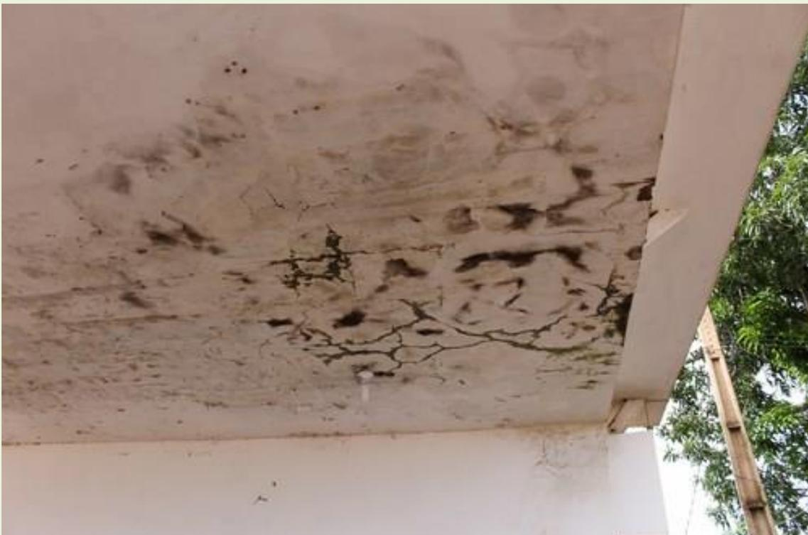
4. Teto da balança com grave infiltração e gotejamento;
