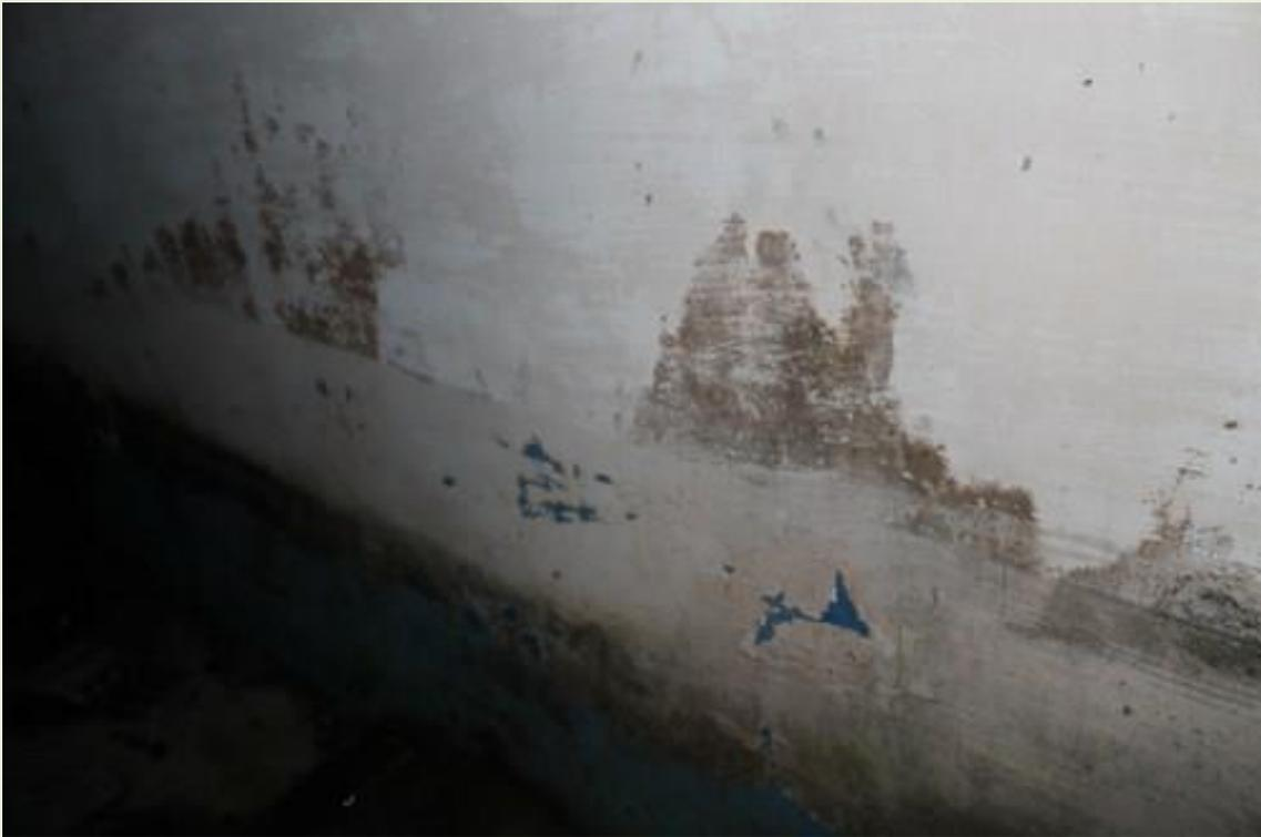
21. Infiltrações nas paredes e teto. Forro quebrado e caindo;
