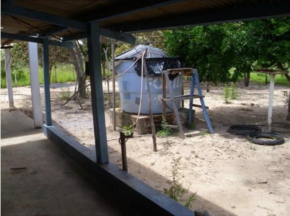
11. Caixa d'água instalada no chão, apesar de tampada, frequentemente encontra-se suja, com insetos e impurezas;
