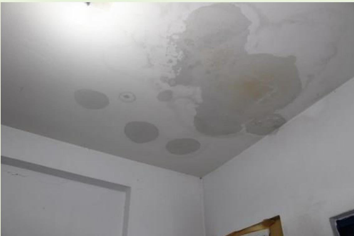
1. Diversas infiltrações e rachaduras no teto e paredes;
