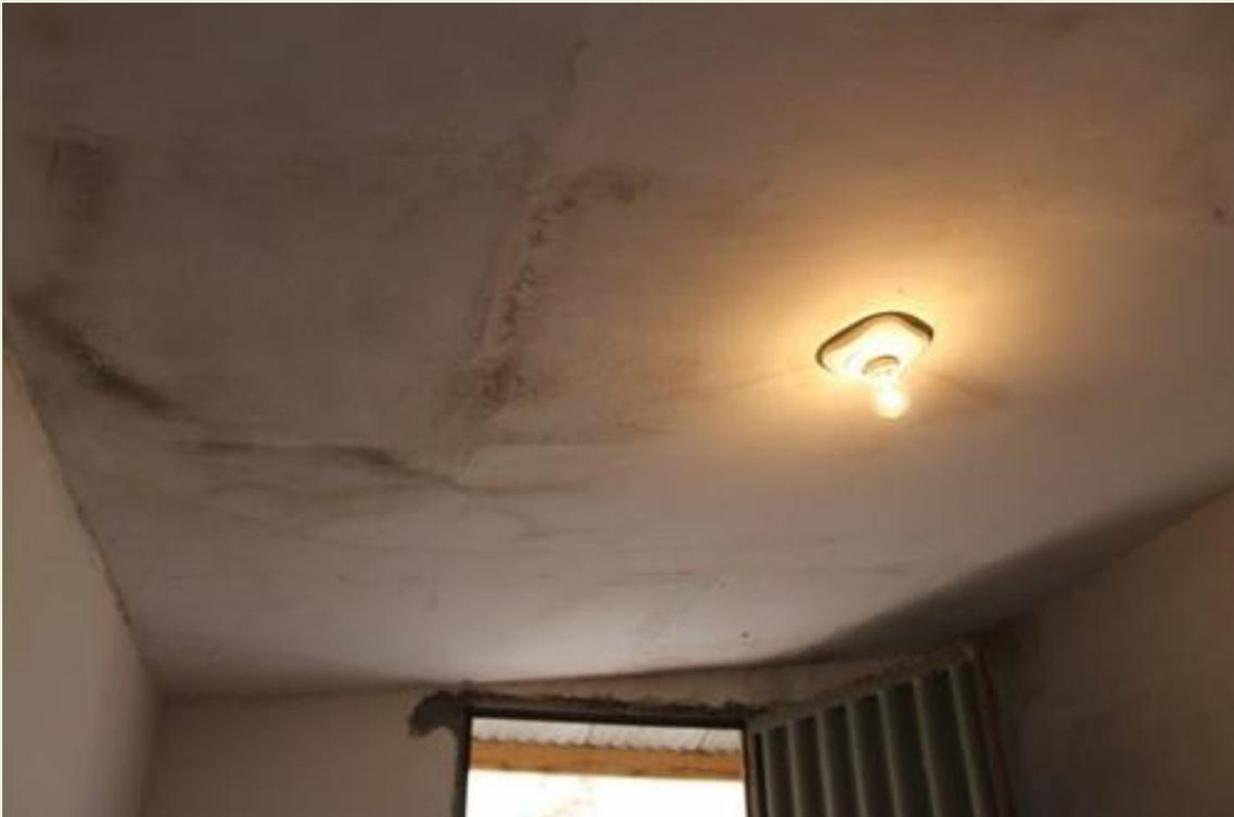
10. Diversas infiltrações, mofos nas paredes, rachaduras, goteira no teto da cozinha, banheiro e quarto;
