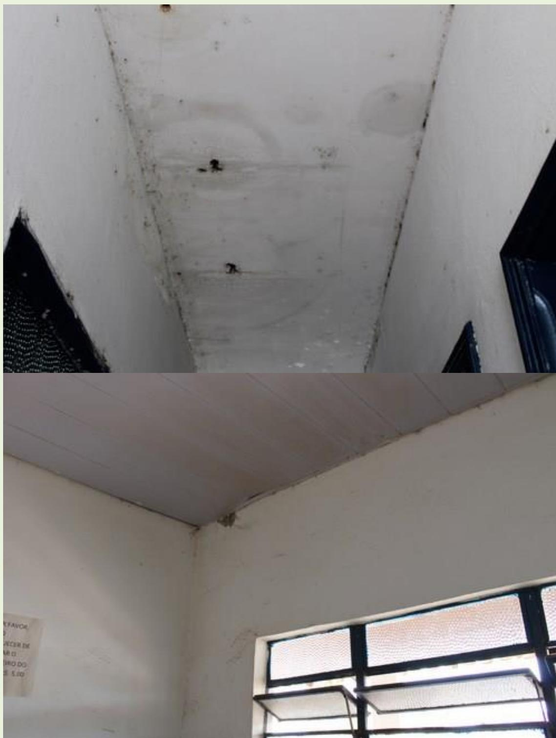
3. Teto e paredes com infiltrações e goteiras;
