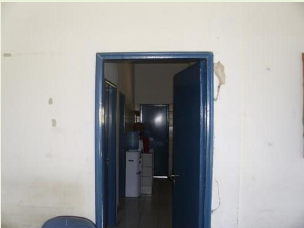
4. Paredes com infiltrações e rachaduras, necessitam de reforma urgente;
