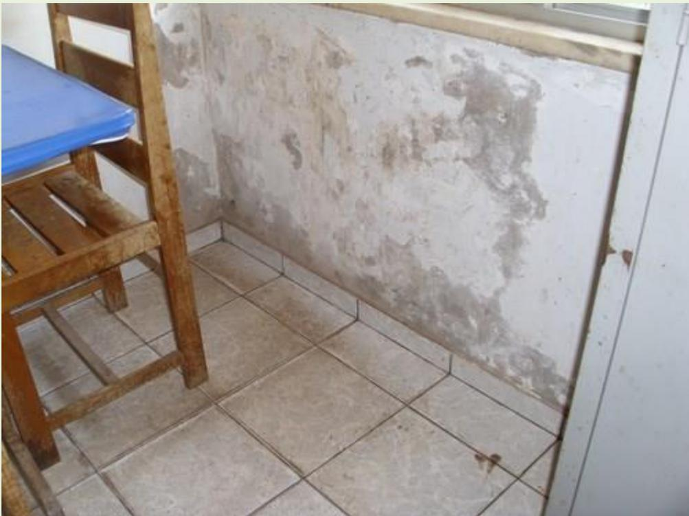
10. Paredes com rachaduras e infiltrações;
