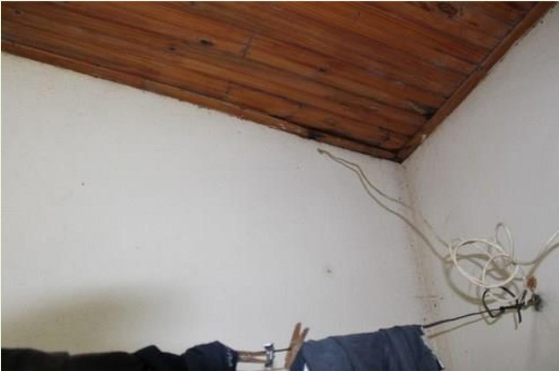
12. Antena satelital mal instalada quebrou o telhado, que provocou bastantes goteiras e água para dentro do posto fiscal;
