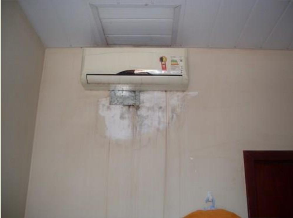
2. Os ares-condicionados da sala de atendimento e do quarto estão precisando urgentemente de manutenção. Diversas infiltrações nas paredes. A sala de atendimento precisa de balde para coletar a água que derrama do aparelho de ar;
