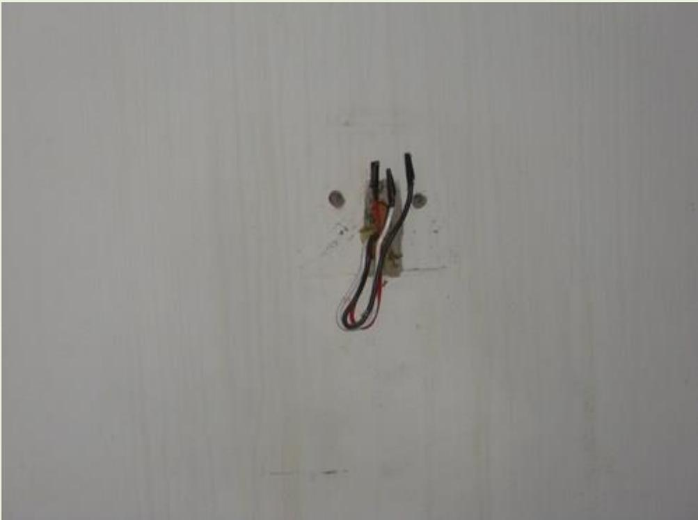
13. Rede hidráulica e elétrica expostas. Necessitam de revisão;
