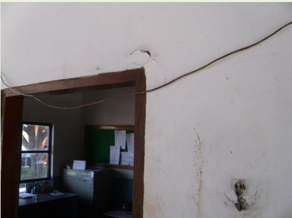
13. Paredes rachadas e fiação solta;
