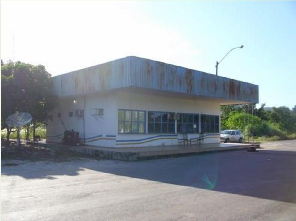
6. Precisa de reforma e aplicação de película de proteção nos vidros devido ao sol frontal na sala de atendimento, pois na parte da tarde, inclusive o sol adentra refletindo e prejudicando o trabalho. Necessita também de instalação de toldo para proteção de sol e chuva;
